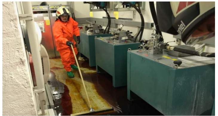
Ölaustritt bei einem Lift am 25.02.2018
